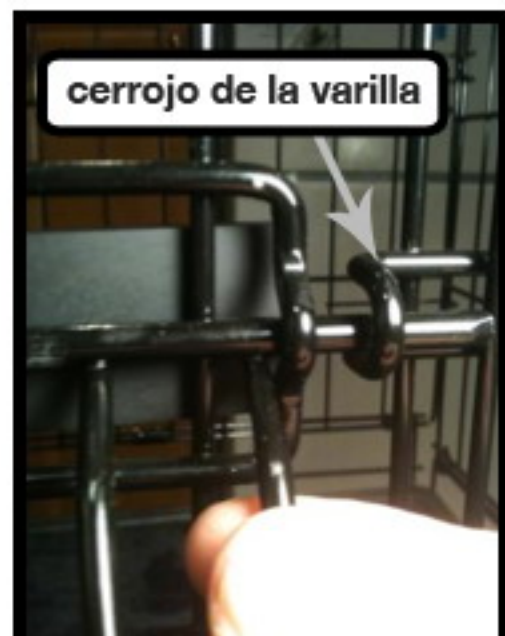
Figura 7: Asegúrese que la manija de la varilla de cierre se deslice libremente en el canal de la unidad y el cierre.
