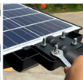
④. Serrare l'installazione con le viti e il gioco è fatto!
