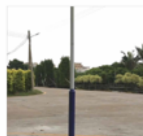
①. ライトポールを金具で柱に固定します。
