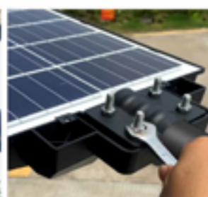
④. ネジを締めて取り付け完了です。
