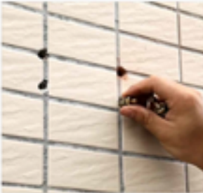
①.Haz un agujero en la pared contra el chasis de la farola.
