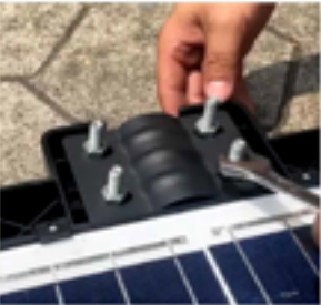
③.Fije los accesorios al cuerpo de la lámpara.
