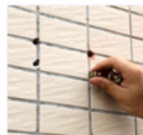
①. 灯柱のシャシに対して壁に穴を開ける
