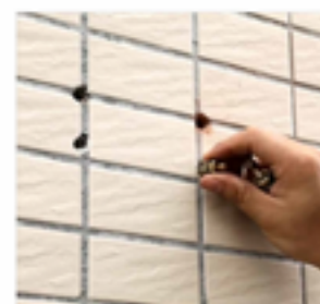
①. Praticare un foro nella parete contro il telaio del lampione.
