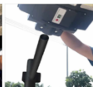
③. Montare la lampada sul palo.
