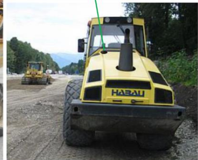
Motorbereich / -haube oder Kabinendach
