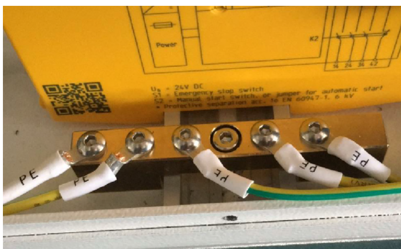
Pic 1.4-1 治具内部接地图示
