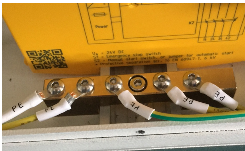
Pic 1.4-1 治具内部接地图示
